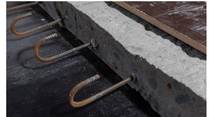
BETONGPLATTAN BILAS BORT FÖR ATT GJUTA NY.
