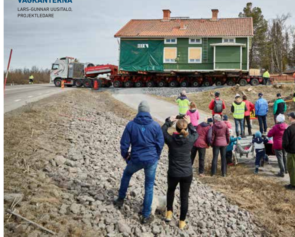
BYGGNAD B5 PÅ VÄG TILL SIN NYA PLATS I LOUSSAVAARA.
