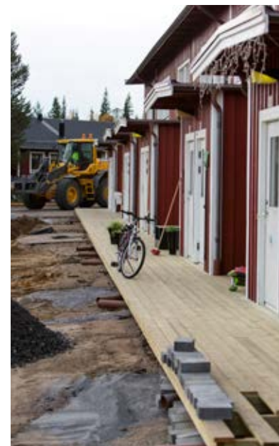
Entréerna till de befintliga bostadshusen görs om.
