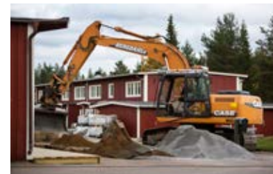
Markarbeten med grundläggning ingår i etapp 2.
