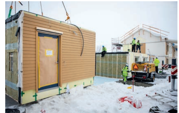
... för att sedan lyftas av med hjälp av en kraftfull kran...
