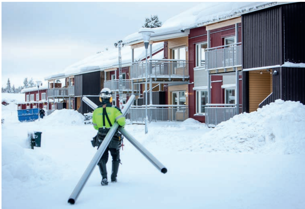
På Granbacka närmar det sig inflyttning i de nya lägenheterna som just nu besiktas.
