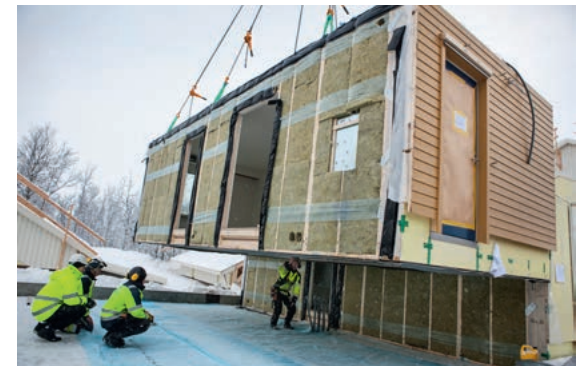
... och slutligen ställas på plats på grundplattan.
