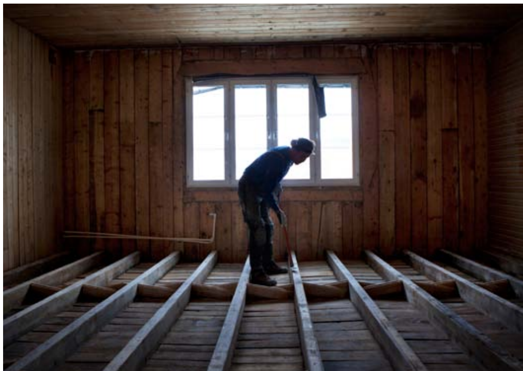
Bengt-Arne Johansson är en av alla som just nu bygger om Jägarskolans kaserner till lägenheter.
