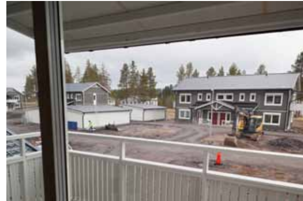
Markarbeten pågår fortfarande.
